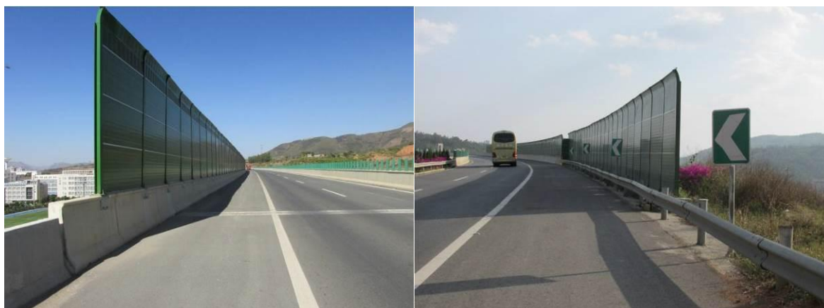
图 5.2-3 声屏障工程实例
