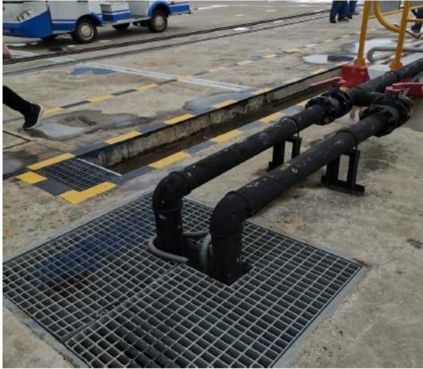
图 6 码头上设置污水提升系统
