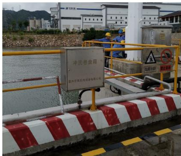
图3 配备冲洗装置控制扬尘
