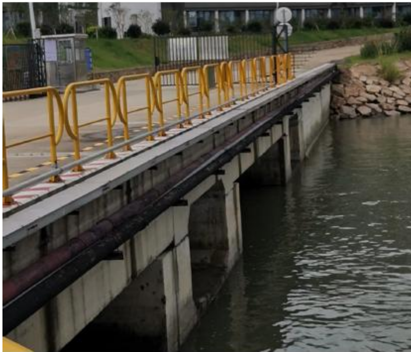
图 7 设置污水收集管道
